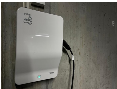
El bil ladestasjon v/ garasje plass.
