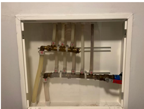
Ingen tegn til fukt/kondens i rør i rør skap.
