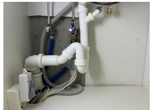
Røropplegg og aquastop under vask.
